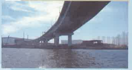
海岸高速線を海上から見上げる
